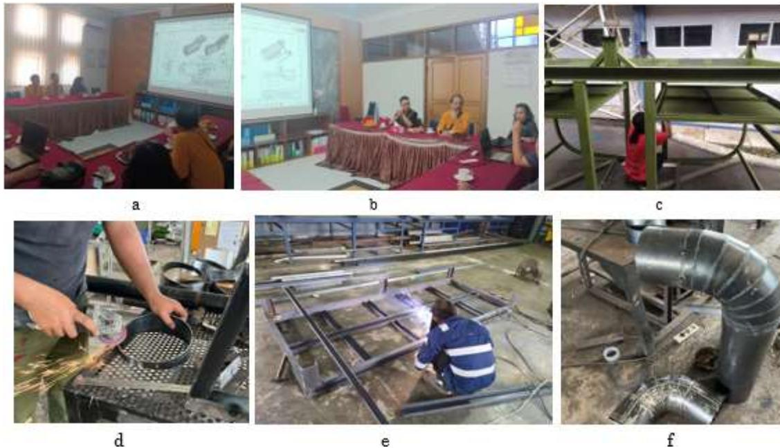
**Gambar 3.** Finalisasi desain dan Pembuatan TTG, (a,b). Desain akhir didiskusikan tim pendamping dan tim pelaksana, (c). Rangka di cat anti karat, (d). Pembuatan Flange, (e). Flange Cerobong, (f). Pembuatan Rangka Mesin pirolisis.
